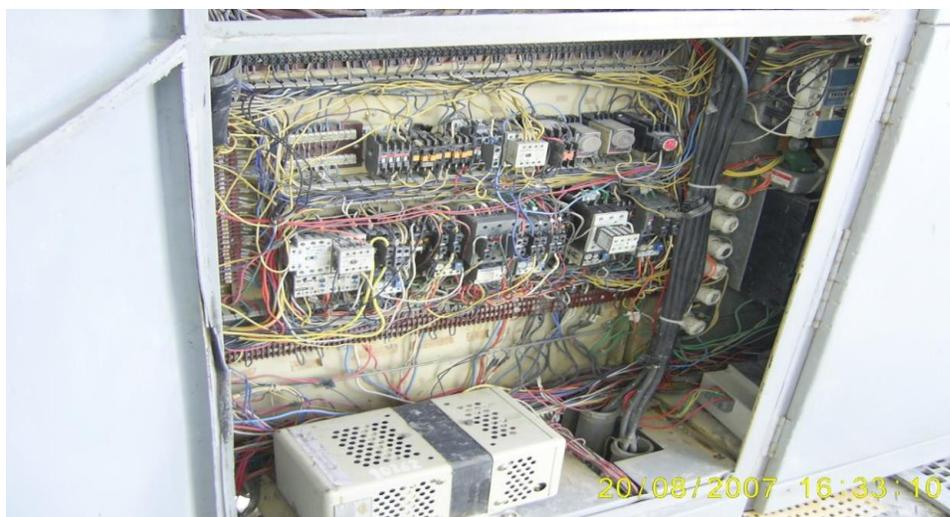
**Figura 10:** *Tablero eléctrico actual de la sección de chancado*
