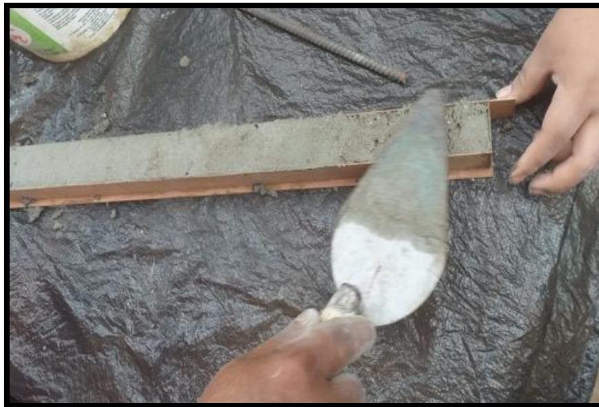
Figura 30 Nivelación del adoquín modificado con conchas de abanico.
