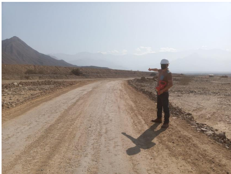
Tramo de la carretera
