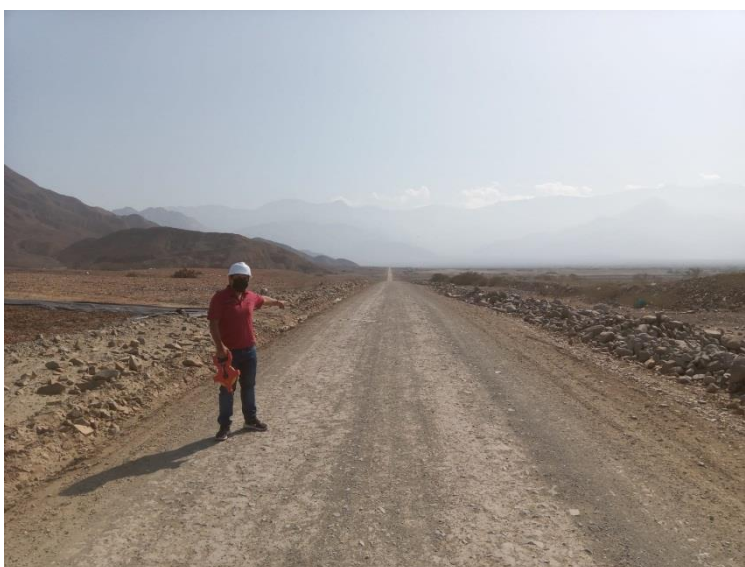
Tramo de la carretera
