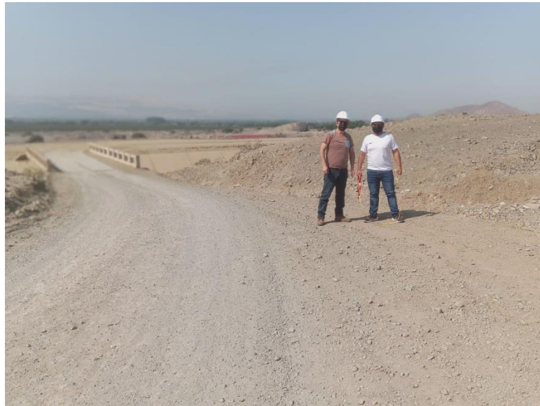
Tramo de la carretera
