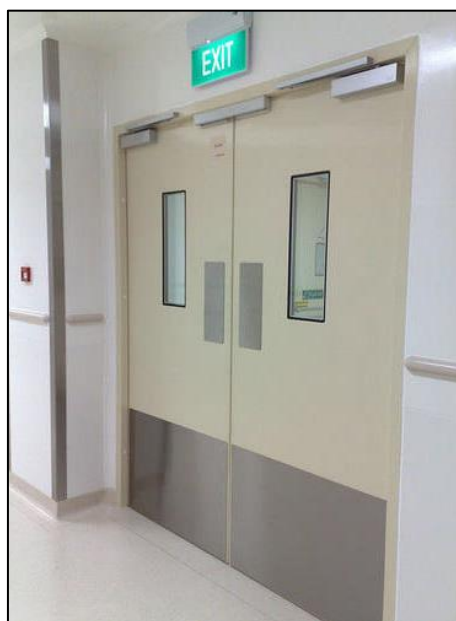
Imagen 42: Puertas de salidas de cierre automático
