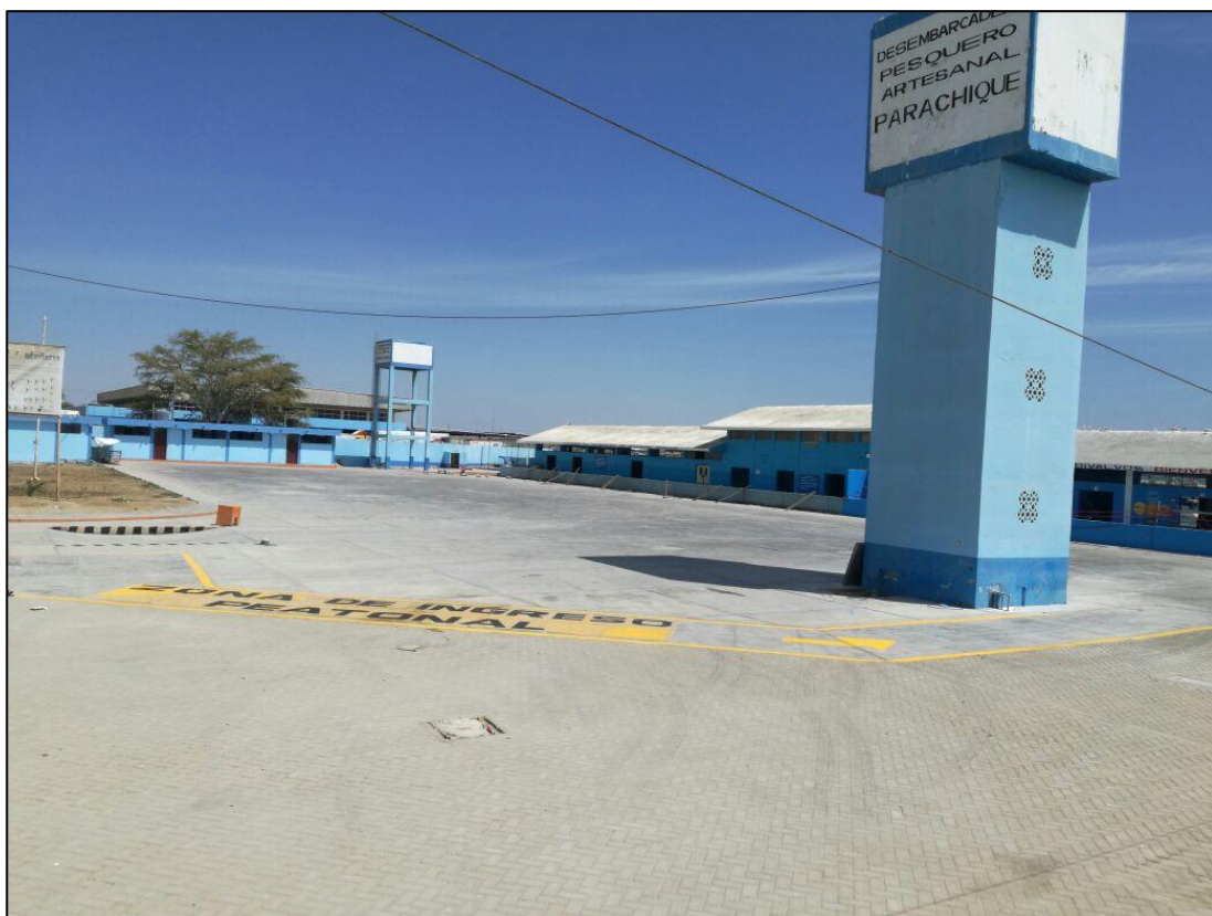
Imagen 31: DPA - zona de patio de maniobras
