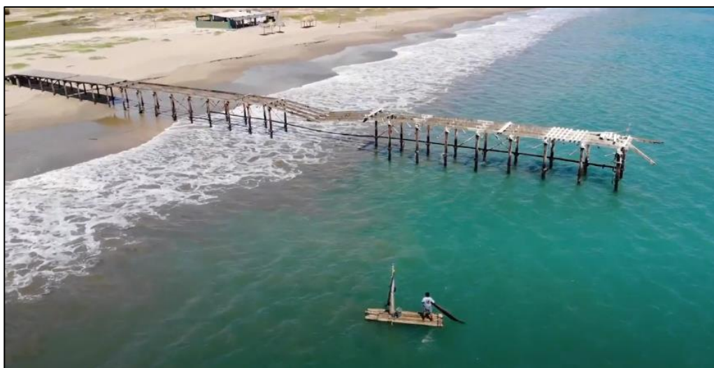
Imagen 18: Muelle Existente de Matacaballo – Sechura – Perú.
