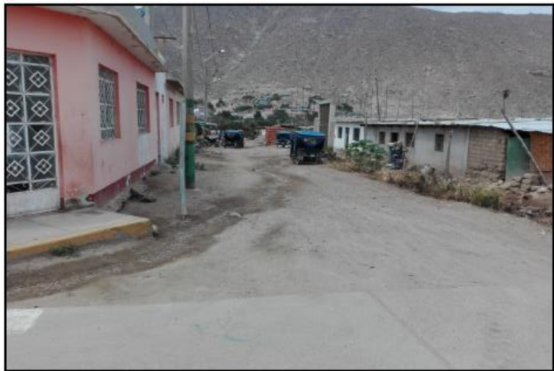
INICIO DEL JIRON PROGRESO PROGRESIVA 00 + 00 Y CALLE SANTIAGO ANTUNEZ DE MAYOLO
