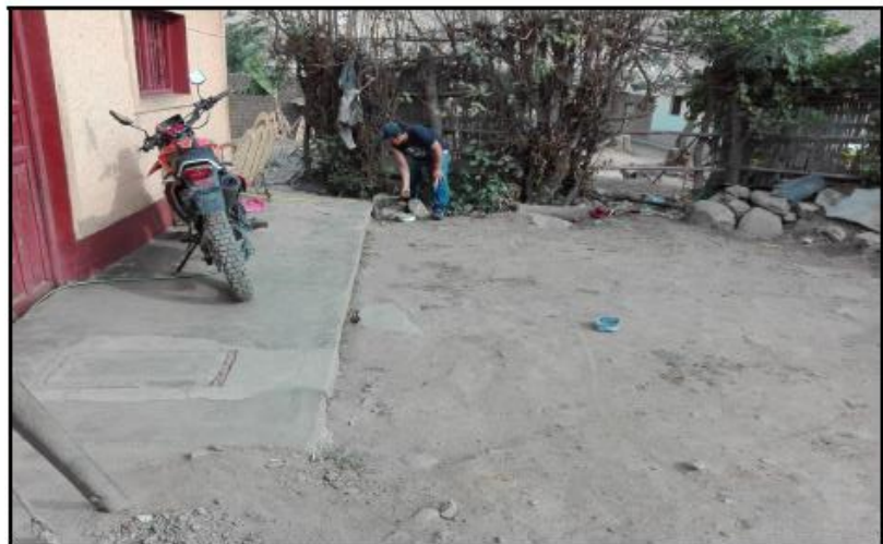
VEREDAS EN MAL ESTADO EN JIRON PROGRESO
