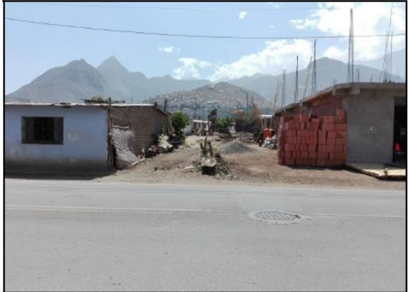
FINAL DEL JIRON PROGRESO PROGRESIVA 00+113.494 Y AV. FRANCISCO BOLOGNESI
