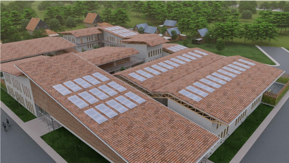
Figura 21. Paneles Solares en Cubiertas
