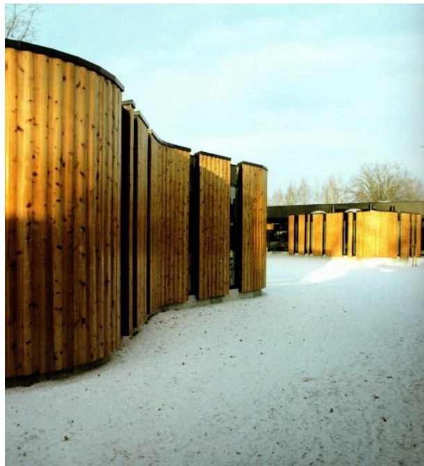
Figura 54. Costado lateral de la escuela.
