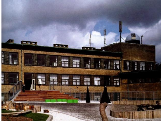
Figura 50. Espacio abierto sobre construcción nueva.
