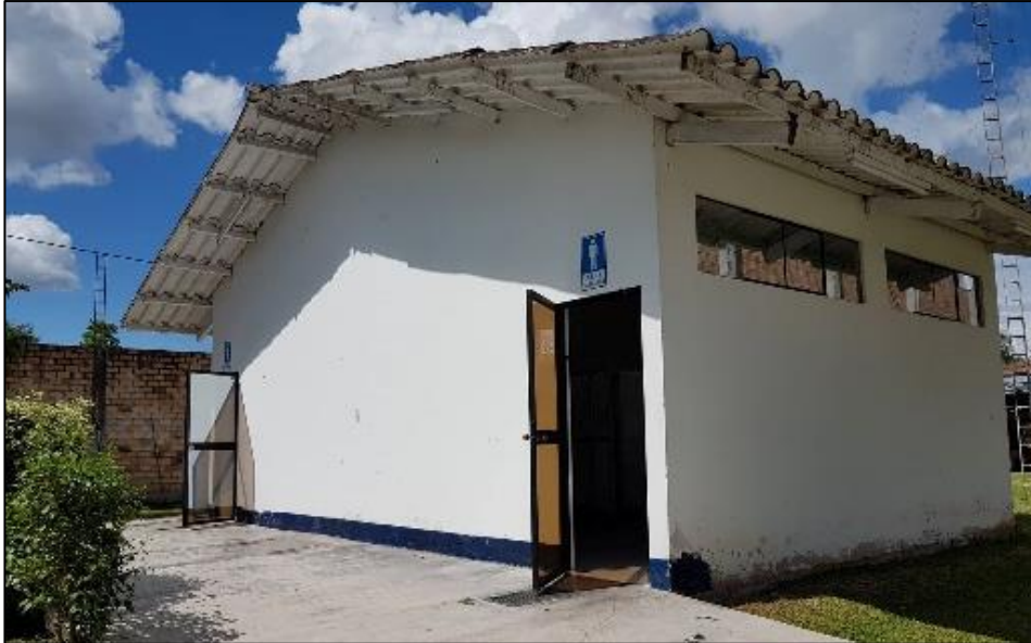
Figura 17. El bloque destinado para servicios higiénicos no tiene el aforo suficiente.
