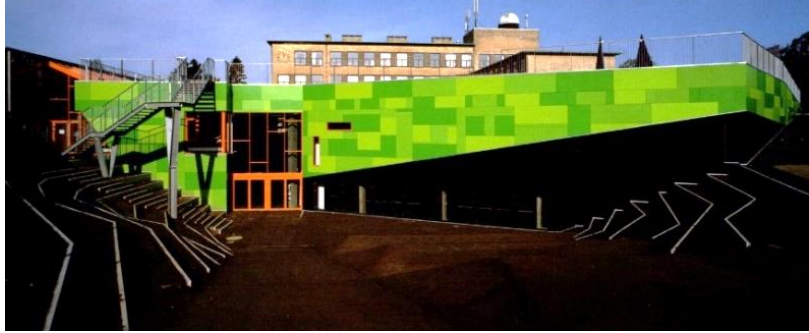
Figura 48. Fachada del centro deportivo de la Escuela Bakkegaard.
