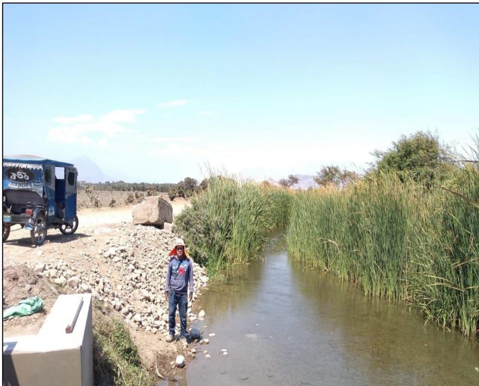
Fotografía 02: Reconocimiento de campo del Canal San Pedro
